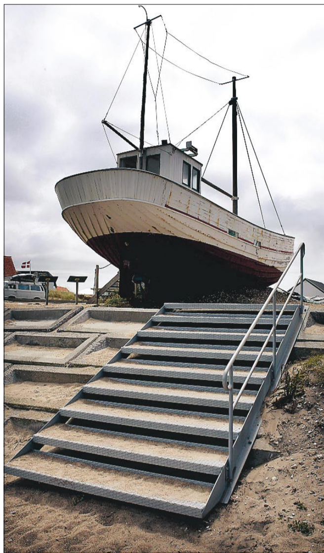
EN NY trappe ned til vandet nord for spilhuset er det også blevet til.
